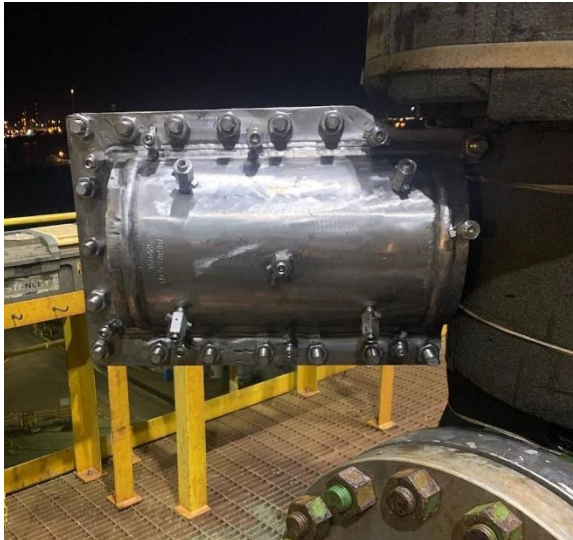
Figura 1. Abrazadera temporal sobre una válvula que fugaba
