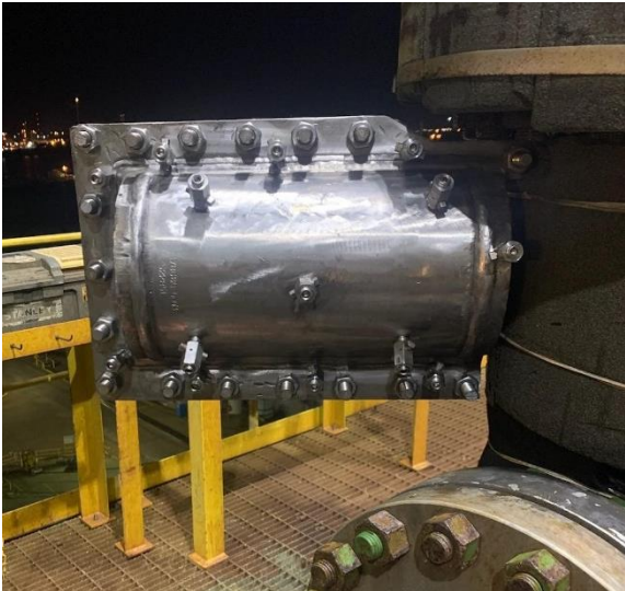
Figura 1. O șarnieră temporară peste un ventil care avea scurgeri
