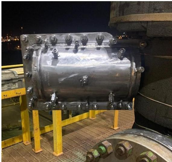
Figura 1. Capote temporário de tubulação sobre uma válvula que apresentava vazamento
