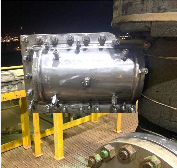
Figura 1. Isang pansamantalang salansan gawa ng tubo sa paligid ng tumatagas na balbula.
