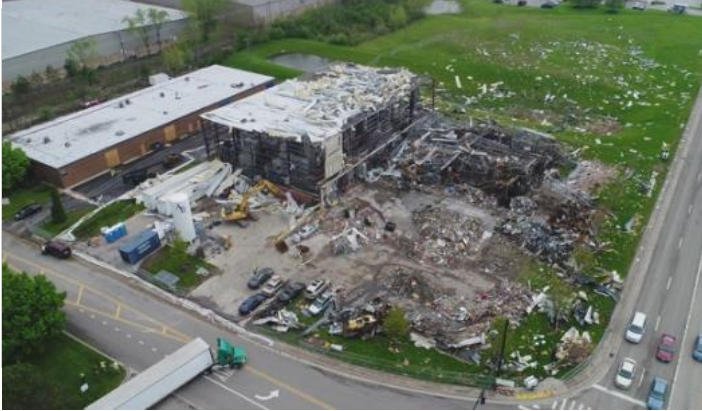
АВ цахиурын байгууламжийн дэлбэрэлтийн дараах зураг (Эх сурвалж: CSB report No. 2019-03-I-IL)
