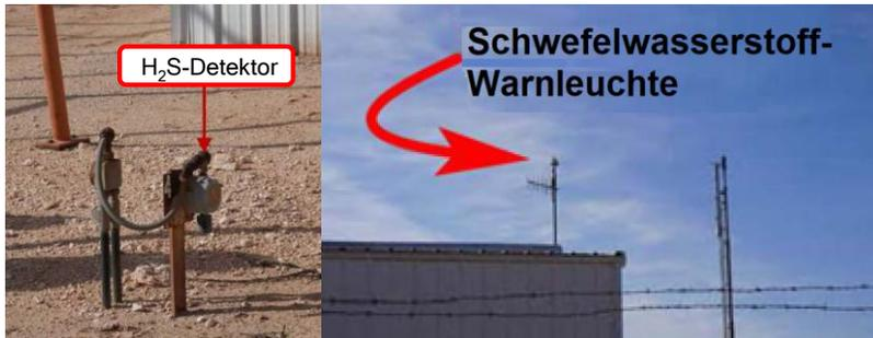
Abb. 1: Einer der H<sub>2</sub>S-Detektoren
