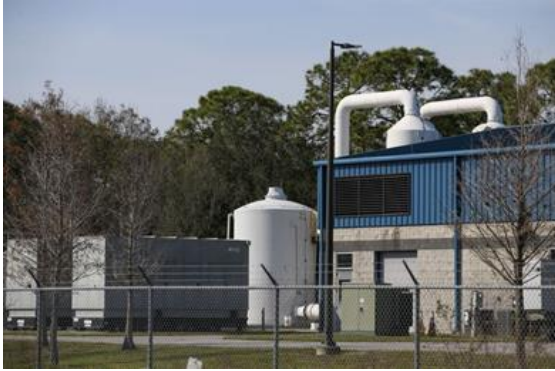
Figura 1. Estação de tratamento de água em Oldsmar, Flórida
