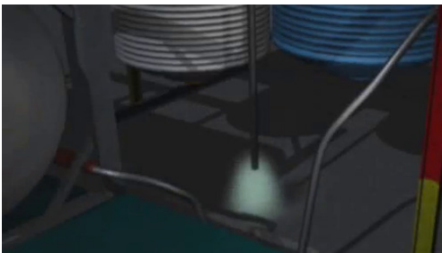
圖2. 製程蒸氣在製程區域附近的低處釋放
