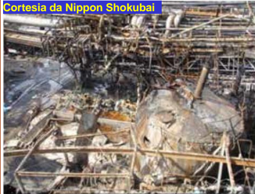
Figura 1: Tanque de AA destruído
