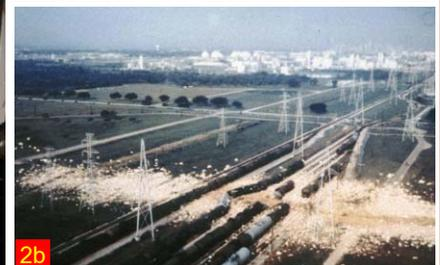
**Incidente 2:** Um vagão tanque contendo ácido metacrílico bruto (MAA) aqueceu e começou a libertar material através da sua válvula de relief. A área foi evacuada, e após algum tempo o vagão tanque explodiu destruindo o vagão e causando danos significativos na área (Figuras 2a e 2b). Porque as pessoas foram evacuadas não existiram danos pessoais.
