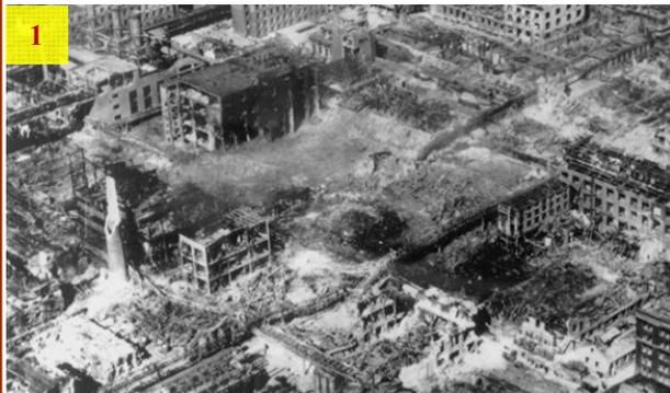
En julio de 1948, un camión cisterna lleno de dimetil éter (DME) llegó a una fábrica en Ludwigshafen, Alemania. Se cree que falló una soldadura tras estar expuesta al sol durante aproximadamente 10 horas. Cerca de 200 personas murieron, casi todas por la explosión de la nube inflamable de DME creada por la fuga. Cerca de 4000 personas resultaron heridas, la mayoría por exposición a sustancias tóxicas provenientes de las instalaciones dañadas por la explosión (Imagen 1).
