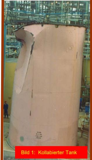
Bild 1: Kollabierter Tank
