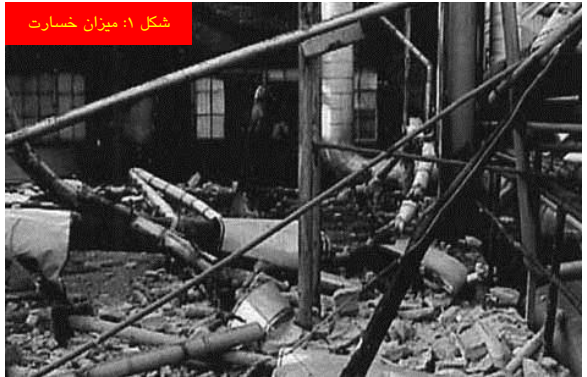
شکل ۲: لوله حادثه دیده
