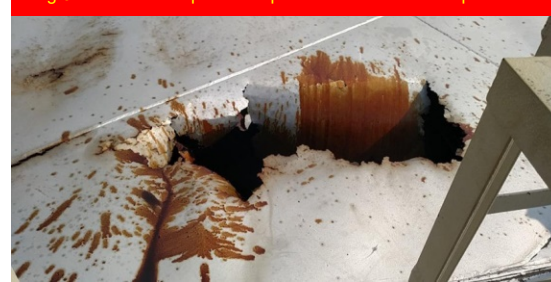
Fig.3 : Buraco no topo de tanque de hidrocarbonetos quentes
