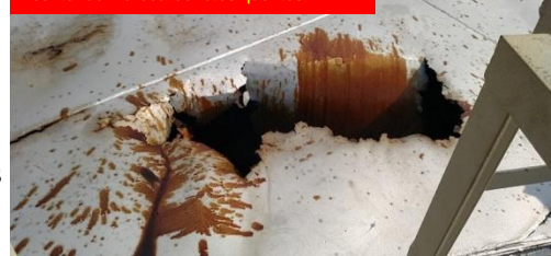
Fig. 3: Buraco aberto no topo de tanque contendo hidrocarbonetos quentes
