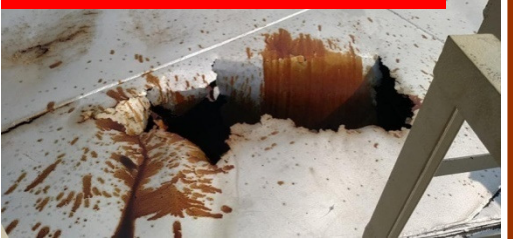
चित्र ३: गरम तेलाच्या टाकीच्या छतामधील छिद्र
