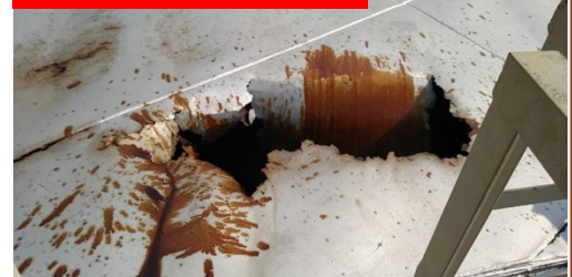
그림 3: 열매유 저장 탱크 지붕의 구멍
