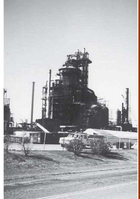
폭발한 압력용기(F7)는 공정중 고체의 촉매가루로부터 중질유를 분리하는데 사용되는 것이었습니다. 가동중지 동안 중질유는 모든 공정 설비에서 배출되어 있었고, 설비는 재 가동을 위해 청소, 검사, 정비되어 있었습니다. 가동개시 절차에 따라, 오일이 공급되기 전에 시스템 내부의 모든 공기를 치환하기 위해 스팀으로 퍼지했습니다. 공정설비의 온도는 이러한 퍼지용 스팀 일부를 물로 응축시키기에 충분히 낮은 상태라는 것이 운전원에게 인지되어 있었습니다. 그래서 이런 응축수는 모여서 F7 용기로 보내졌습니다. 일반적인 가동개시 절차는 운전원이 고온의 오일이 유입되기 전 F7로부터 물을 빼내도록 되어 있었습니다. 그러나, F7에서 물이 빠지지 못하게 차단밸브 하나가 오류로 잠겨져 있었습니다. 수증기의 급팽창에 의해 F7은 과압되었고, 결국 격렬히 파열되었습니다. 폭발로 오일이 누출, 점화되었으며, 화재는 FCC공장을 휩쓸었습니다. 화재는 완전히 진화되기까지 약 2시간 반 동안 진행되었습니다.
