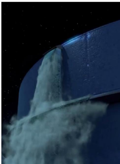
Isto é similar a um incidente industrial, que o pioneiro de segurança de processo Trevor Kletz descrevia frequentemente nas suas palestras. Durante muitos anos era bombeado material para um tanque em operação manual, sem incidentes. Uma vez houve um pequeno derrame por sobreenchimento, que o operador rapidamente parou. A recomendação da investigação do incidente foi adicionar um alarme de nível alto que cortasse a alimentação ao tanque, se o operador não o fizesse, e isto foi efetuado.
