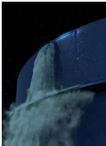
これはプロセス安全の先駆者、Trevor Kletzがしばしば話していたプロセス産業の事故と同じように思われる。長年事故もなくある液体が手動操作でタンクにポンプ移送されていたが、ある日少量のオーバーフローがあり、オペレーターはそれを素早く止めた。その事故の調査後、オペレーターが移送を止め損なった場合に、タンクへの供給を止めるハイレベルアラームを追加することが勧告され、それは実施された。
