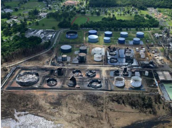
Yangından sonra tesiste hasar
