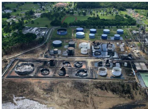
Ζημιές στην εγκατάσταση μετά τη φωτιά
