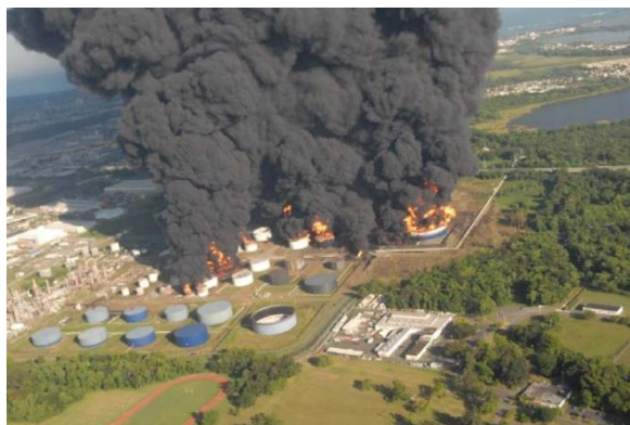
Πυρκαγιά σε δεξαμενές αποθήκευσης
