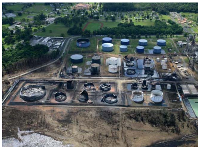
Dommages survenus au site après l'incendie
