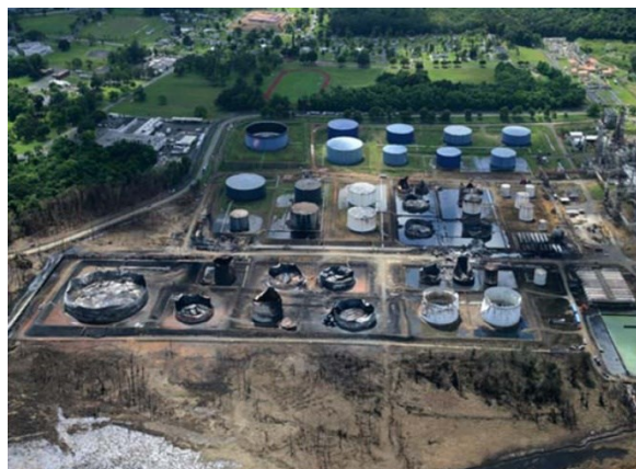
Škody na majetku po požáru
