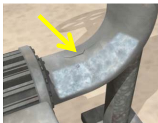
Există o fisură pe această conductă?
