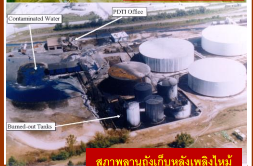
เพลิงไหม้ที่ลานถังเก็บ
