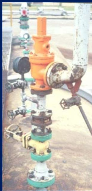
En el Beacon de Noviembre 2012, muchos lectores identificaron correctamente un problema de seguridad con la válvula de alivio de la Fig. de la izquierda: el posible cierre de una válvula de bloqueo, aislando la válvula de alivio, y eliminando la protección contra una presión excesiva. Un segundo problema posible, un sistema de tuberías que puede causar el castañeteo de la válvula de alivio, no fue identificado por muchas personas.
