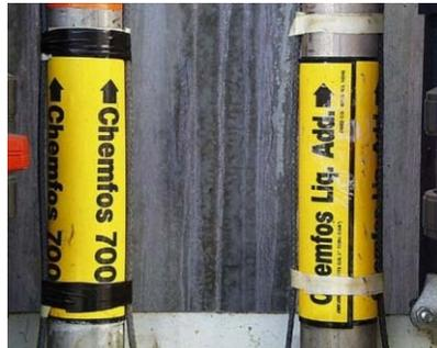
Etiquetas similares en estas tuberías contribuyeron a descargar material equivocado en un tanque de almacenamiento. Se produjo una reacción química, resultando en la liberación de un gas tóxico que afectó a seis personas. Ver el Beacon de Abril 2012.
