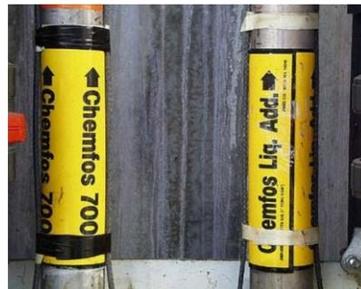
Des étiquettes similaires sur ces deux conduites contribuent au déchargement du mauvais produit dans un réservoir d'entreposage. Une réaction chimique s'en suivit libérant un gaz toxique qui blessa 6 personnes. Voir le bulletin *Beacon* d'avril 2012.
