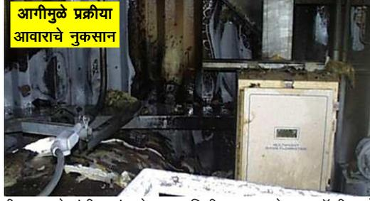
सांडलवंडीमुळे कारखान्यातील काही प्रक्रीया उपकरणे, वाहीन्या. लोखंडी सांगाडे व जमिनीवर वाळलेल्या पॉलीमरचे आवरण तयार झाले होते. कचऱ्याच्या झममधील आग या साटलेल्या पॉलीमरवर पसरली. परिणामी खूप माकठी आग लागली जिच्यामुळे इमारत, प्रक्रीया उपकरणे, नियंत्रण उपकरणे यांचे मोठे नुकसान झाले. जरी कोणालाही इजा झाली नाही तरी कारखाना खूप काळ बंद राहिला आणि काही शे सहस्त्र डॉलर्सचे नुकसान झाले.
