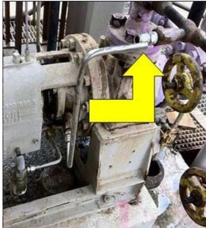
در واحدهای فرآیندی نصب صحیح، تعمیرات و بازرسی از لوله های فلزی نقش مهمی در پیشگیری از نشت مواد سمی و آتش سوزی ها دارد. این لوله ها همیشه قطر کوچکی دارند بنابراین نظارت و بازرسی آنها را به دلیل کوچک بودنشان فراموش نکنید. کوچکترین نشتی از این لوله ها می تواند باعث شروع آتش سوزی و گسترش آن شود و یا حتی نشت مقادیر کمی از مواد سمی بسیار خطرناک باشد. برخی از حوادث گزارش شده در زیر آمده است:
