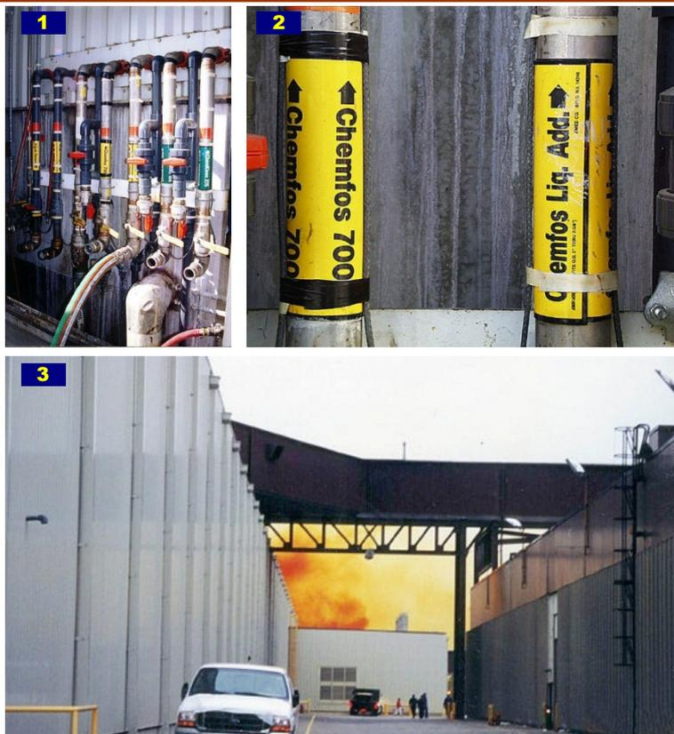
送貨卡車到達某工廠，載著硝酸鎳與磷酸的溶液—供應商取名為“Chemfos 700”。廠裡員工引導卡車司機至卸料站，並派一名管道安裝工(pipefitter)協助卸料。管道安裝工打開控制板，內有6個管接頭(圖1)，分別接至不同的儲槽。每個卸料的管接頭皆有標籤標示存放在儲槽內物質的廠內名稱。卡車司機告訴管道安裝工說他要送交Chemfos 700。
