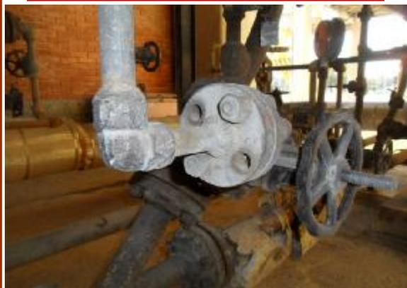
На фотографиях показаны фланцы с неправильными болтовыми соединениями, обнаруженными в ходе заводской инспекции по безопасности оборудования. На фото сверху при сборке фланцев использованы (либо все, либо частично) слишком короткие болты, гайки сидят на болтах не полностью. Последнее означает что сболченное соединение может оказаться недостаточно прочным. Фланцы конструируются так, что только полностью навинченная на болт, правильно затянутая гайка способна выдержать расчетную нагрузку.
