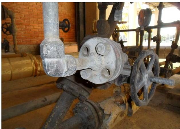
Gambar-gambar yang menunjukkan bebibir tidak diperketatkan dengan betul bahawa loji yang dijumpai semasa pemeriksaan keselamatan. Dalam gambar atas, beberapa atau semua bolt terlalu pendek, dan nut tidak sepenuhnya pada bolt. Ini bermakna bahawa sendi mungkin tidak kuat seperti yang sepatutnya. Bebibir direka bentuk supaya bolt - nut gabungan memegang keseluruhan kuasa-kuasa pada bebibir. Jika nat hanya sebahagian diskrukan ke bolt, sambungan mungkin tidak cukup kuat.
