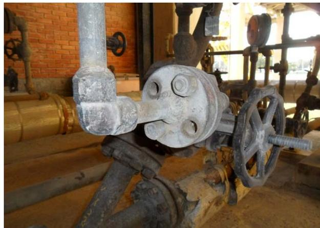
Auf den Bildern erkennt man unsachgemäß montierte Flansche, die bei einer Sicherheitsbegehung gefunden wurden. Auf den oberen Bildern sind Schrauben zu kurz, so dass die Muttern nicht ordnungsgemäß sitzen. Somit ist die Befestigung nicht ausreichend. Gemäß Auslegung der Flansche werden die Kräfte nur durch ordnungsgemäße montierte Schrauben und Muttern gehalten. Ist die Mutter nur teilweise auf dem Gewinde, ist die Verbindung eventuell nicht widerstandsfähig genug.
