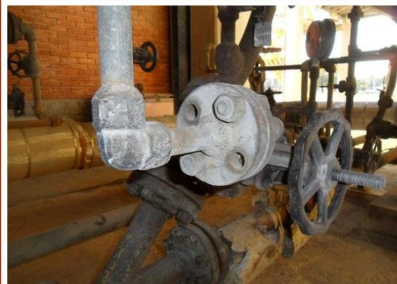
这些图片展示的是不正确的螺栓连接的法兰，它是某工厂在安全检查中所发现的。在上面三张图片中，法兰上有些螺栓长度不够，有的法兰甚至所有的螺栓长度都不足，因此螺帽没有完全拧到螺栓上。这意味着这种连接可能达不到其应有的强度。法兰的设计是考虑到用整套螺帽——螺栓的连接来承受法兰上的力。如果螺帽只部分地套在螺栓上，那么这个连接就可能没有足够的强度。
