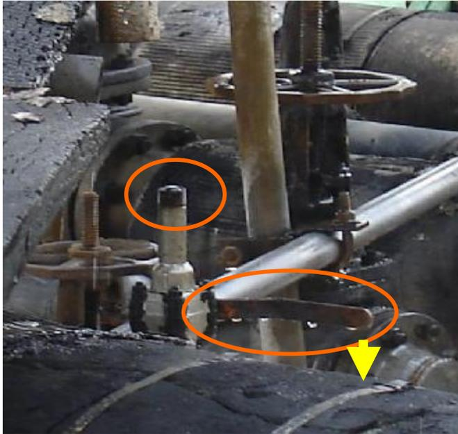
Деталь временного строительного настила для строителей упала сверху на торчащую горизонтально ручку шарового клапана, открываемого поворотом ручки на ¼ оборота, в составе ¾-дюймового (около 20 мм) вентиля, который запирает трубу процесса. От удара ручка повернулась открыв запорный вентиль.
