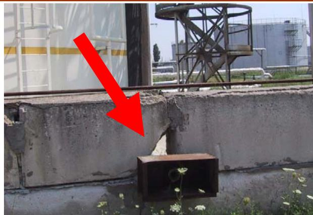
A seta mostra um buraco numa bacia de retenção. Podemos ainda observar danos na base e no topo da parede da bacia. Outros exemplos de danos incluem fissuras nas paredes ou no fundo das bacias de retenção, buracos criados para permitir a passagem de tubagem através das paredes das bacias, e outras situações que permitem o escoamento do produto derramado para fora das áreas de retenção.
