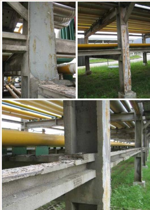
← 这些是钢管桥架支撑的阻火材料被损坏的例子——阻火材料被移除，阻火性能退化和阻火材料脱落。
