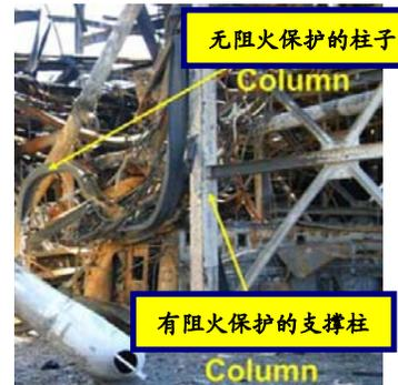
2010年4月的《工艺安全警示灯》讨论了使用阻火材料来保护工艺管道上的部件，特别是保护长螺栓无法兰阀。阻火就是使用阻火绝热的材料（也常用于结构钢的表面）来延缓大火产生的热量传递到钢结构上。主要的目的是在火被扑灭或其它能应对的灭火系统提供足够的冷却保护之前，提高结构钢的耐受能力以保证其完整性。如果没有阻火材料的保护，裸露的结构钢，例如上面左图中的管架支撑柱，或右图中的支撑柱，就可能在几分钟之内迅速失去刚性而坍塌。管道和设备支撑的坍塌将对管道和容器造成破坏，从而导致更多的可燃性材料泄漏，产生更大的火灾。
