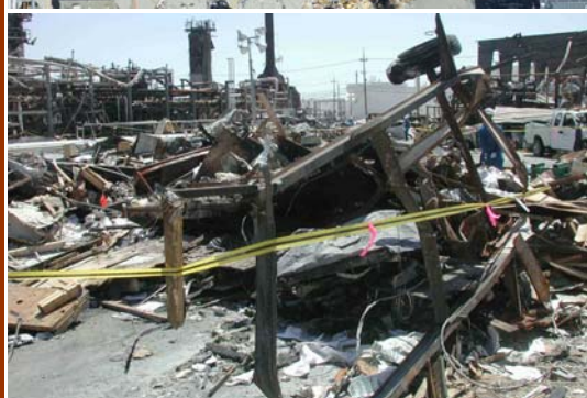
Danos nos atrelados resultantes da explosão em Texas City, Março de 2005
